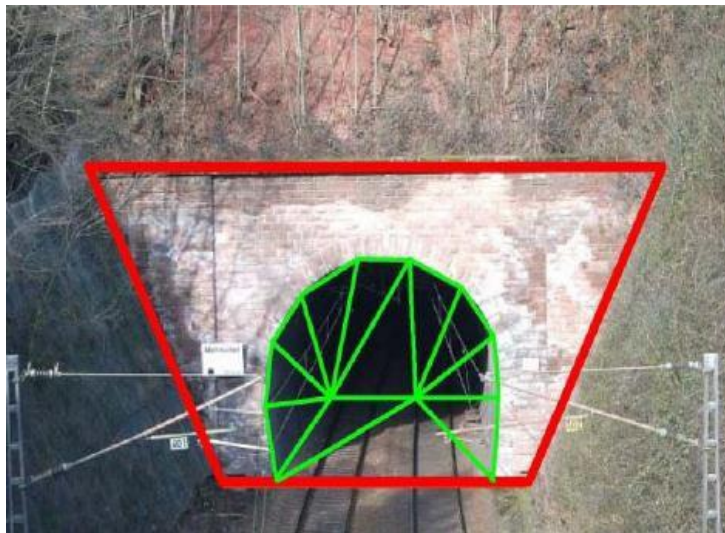
Figuur 7: TIC (de buitenomtrek van de opening (groen)) en getrianguleerde ClosingSurface (groene TINs).
